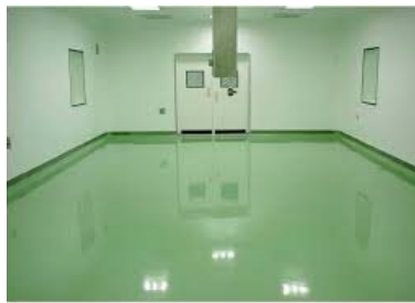
[그림 8. 실습실 바닥 설치 현황]
